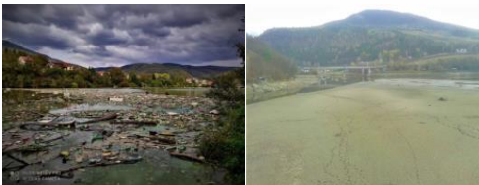
Réservoir Ružín rempli de déchets et de sédiments et déjà régulièrement asséché (2020, 2016)
