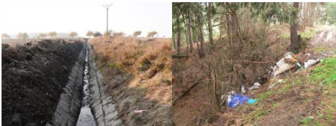
Les canaux de drainage dans tout Spiš contribuent au drainage rapide des eaux de pluie vers Hornád, y compris les déchets, qui sont dispersés dans presque tous les districts du bassin du Hornád. (2015)
