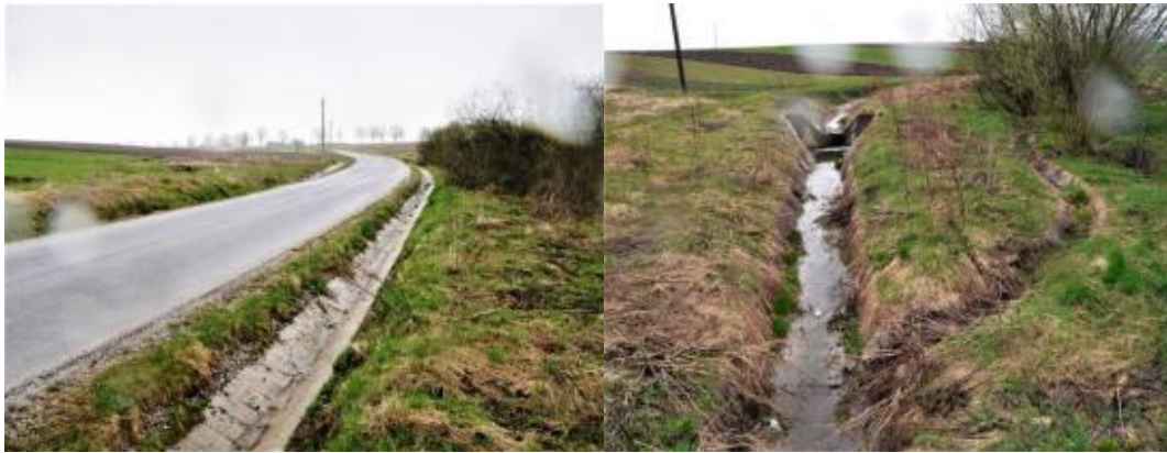
Chaque canal du bassin du Hornád est aidé par un remplissage rapide avec les eaux de crue et les sédiments. Barrages de Ružín (2015)
