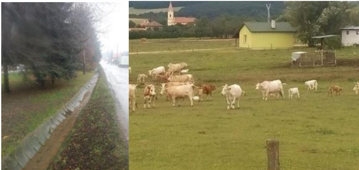
Gestion des eaux pluviales dans la zone urbaine de Štítnik et des pâturages à Gemerská Panica
