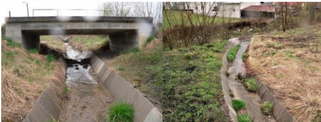
Appliquer l'ancien paradigme de l'eau pour évacuer les eaux de crue dans la rivière le plus rapidement possible Hornádu contribue à l'envasement du barrage de Ružín
